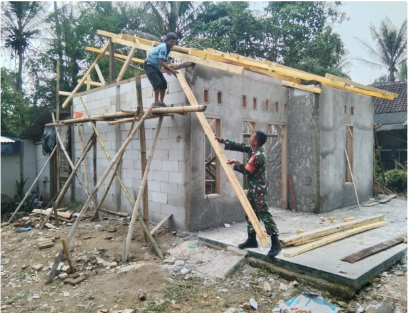
Serda Naya membantu pemasangan atap RTLH
